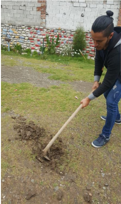
Practicante Manuel Torres, inicia la construcción del caudal.
