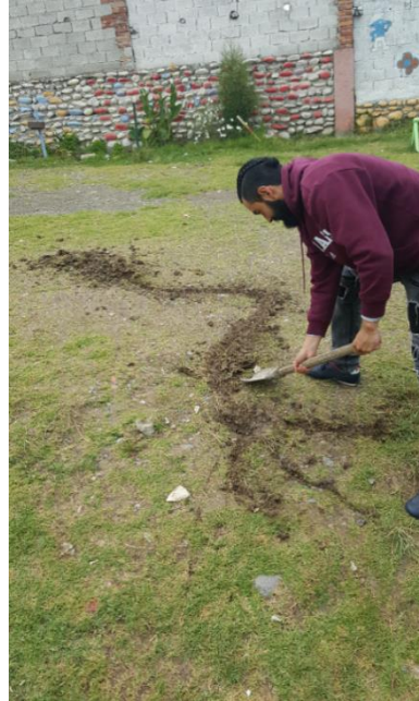
Practicante Joffre Rojas, realiza la construcción de las margenes del río.
