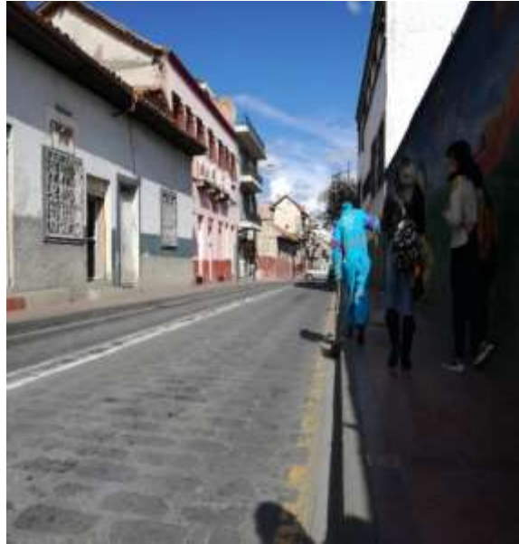
Imagen 2. Vista de la escuela desde la calle Gaspar Sangurima Fuente: fotografía tomada por las investigadoras.
