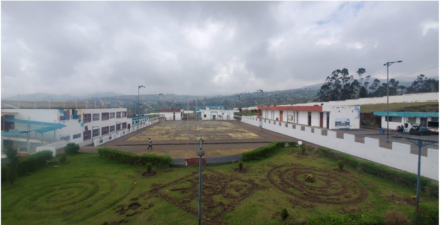
Ilustración 3. Estado actual de la UEM Quisapincha Fuente: Imágenes de autoría propia.
