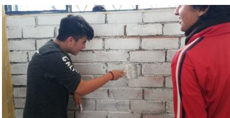
Foto 3. Proceso de adecuación.
