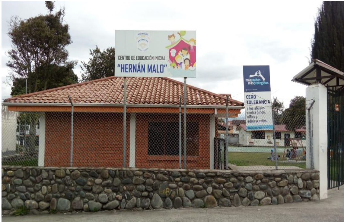
Fotografía 1. Fotografía del exterior del CEI Hernán Malo.
