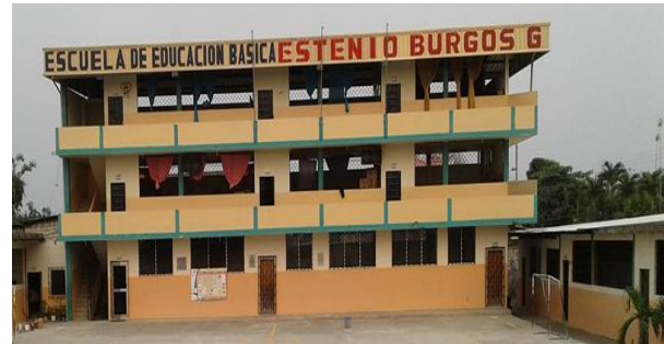
Figura 1: Infraestructura de la institución
